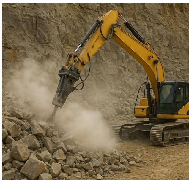
Joonis 5. Hüdrovasaraga kobestamine.
