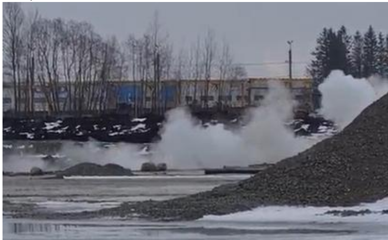
Joonis 4. Lõhketöödega kaasneb osakeste heide lõhatava materjali purunemisest ja lõhkeaine koostisest sõltuv gaasiliste saasteainete heide. Foto: OÜ Inseneribüroo STEIGER, 2025
